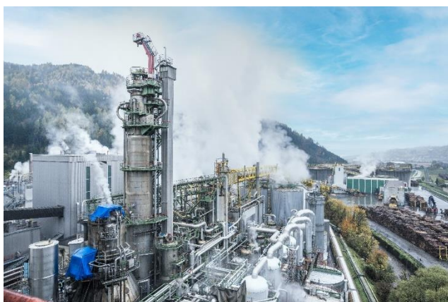
Blick auf den kontinuierlichen Kocher von Mondi Frantschach, wo die Optimierung durchgeführt wurde
